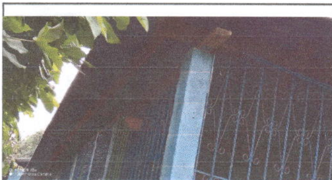
Foto 3: Sustitución de estructura de soporte de madera por metal 2*3 tubo chapa 16
