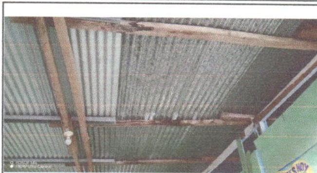
Foto 2. Mantenimiento a estructura de soporte de madera, por metal costanera GLV 3*2 No. 18
