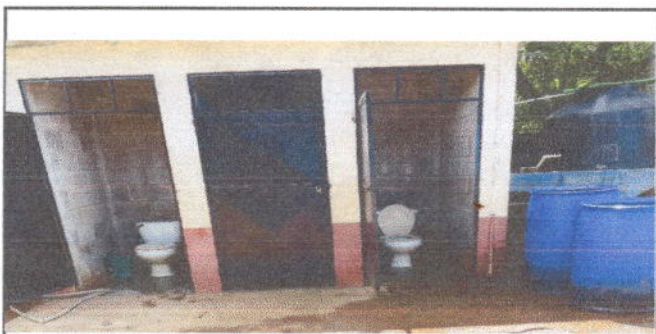
Foto 5: Sustitución de inodoro.
